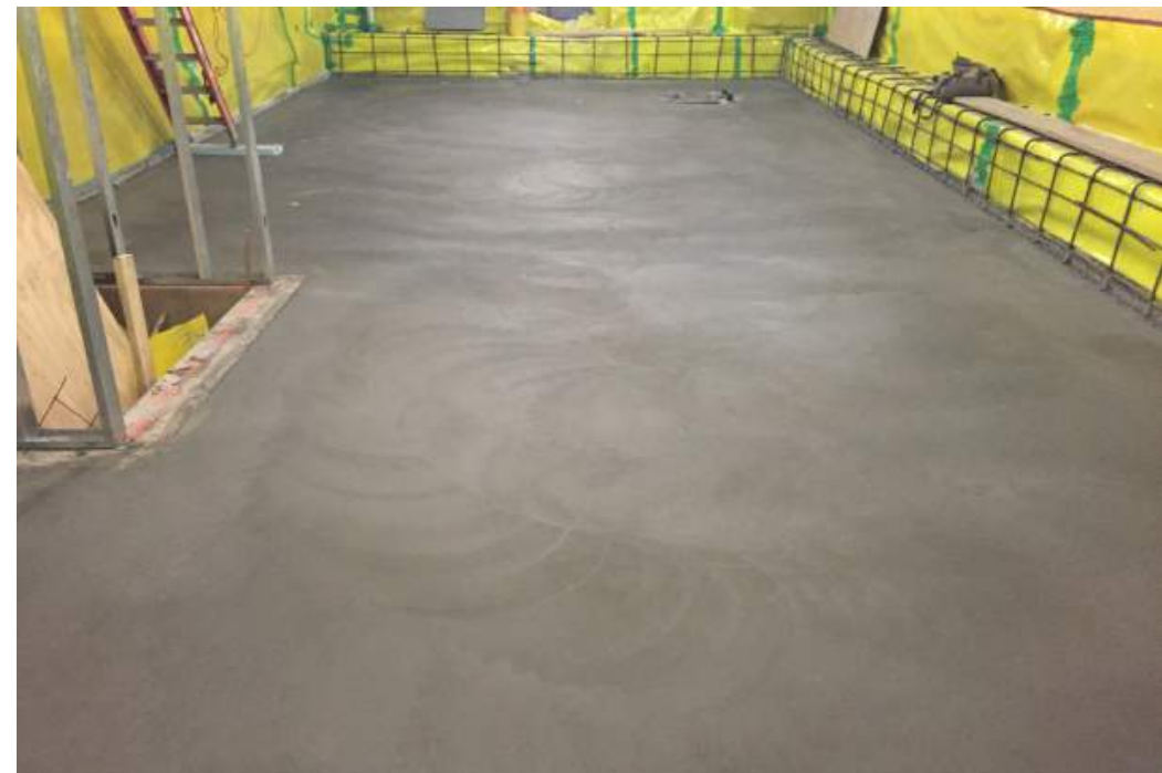
CONCRETE SLAB FILL
